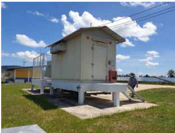
สภาพอาคารระบบไฟฟ้า (Power House No. 1)
