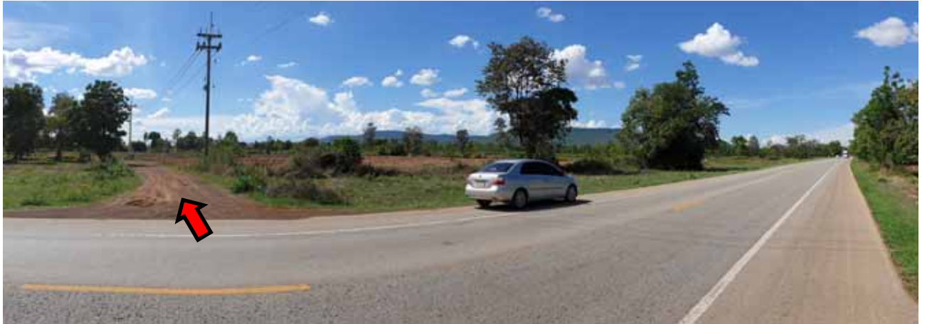
สภาพถนนหน้าวัด (ทล.348) บริเวณหลักกิโลเมตรที่ 26-27 แยกเข้าถนนสายโรงไฟฟ้า (จุดถ่ายภาพที่ 1)
