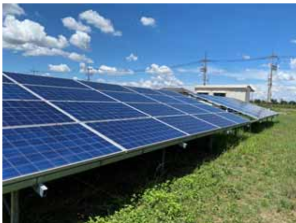
แผงโซลาร์เซลล์ เป็นประเภท Poly Crystalline ยี่ห้อ CANADIAN SOLAR ขนาด 310 W
