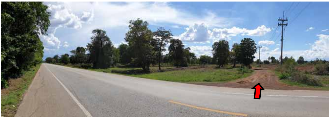
สภาพถนนหน้าวัด (ทล.348) บริเวณหลักกิโลเมตรที่ 26-27 แยกเข้าถนนสายโรงไฟฟ้า (จุดถ่ายภาพที่ 2)
