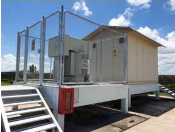
สภาพอาคารระบบไฟฟ้า (Power House No. 5)
