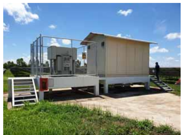
สภาพอาคารระบบไฟฟ้า (Power House No. 4)
