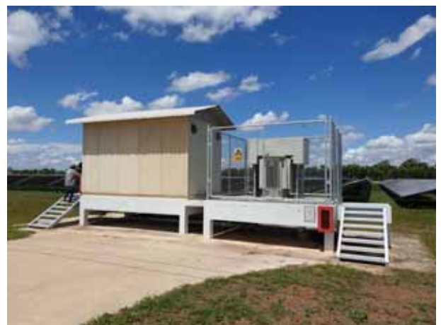
สภาพอาคารระบบไฟฟ้า (Power House No. 2)
