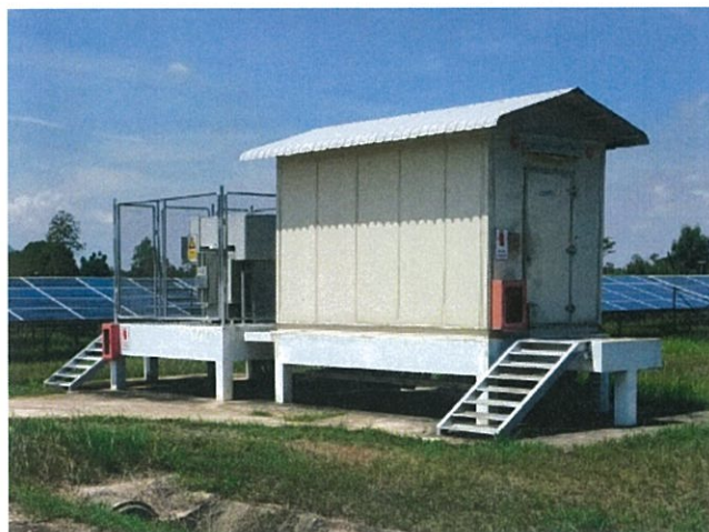
สภาพอาคารระบบไฟฟ้า (Power House No. 3)
