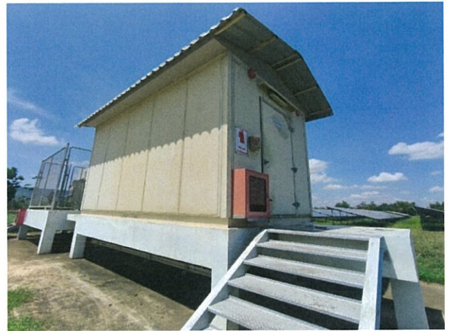
สภาพอาคารระบบไฟฟ้า (Power House No. 6)
