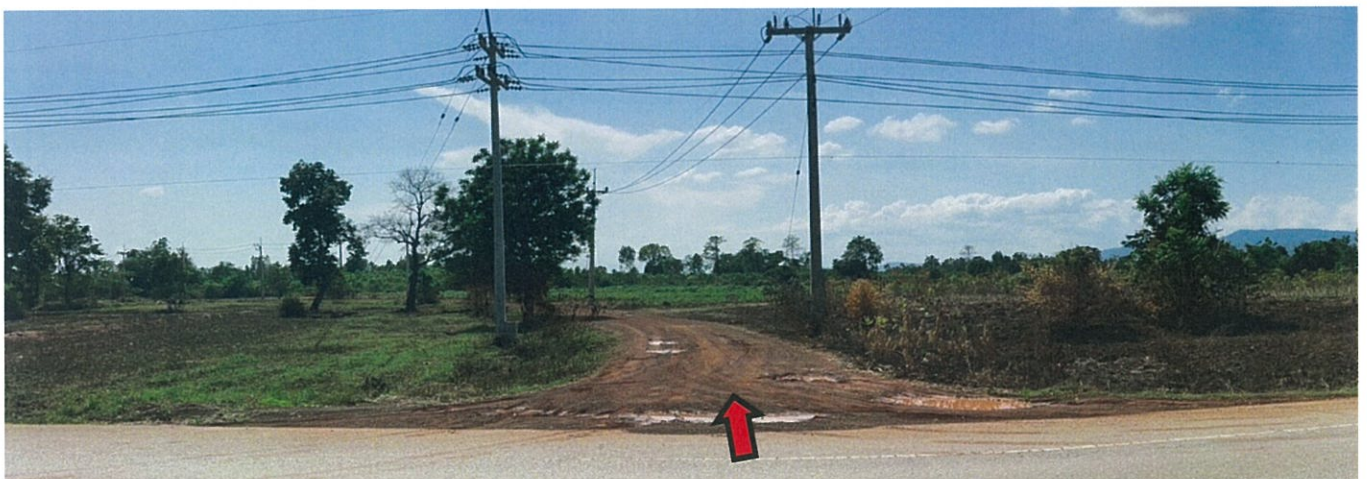
สภาพถนนสายโรงไฟฟ้า (จุดถ่ายภาพที่ 3)
