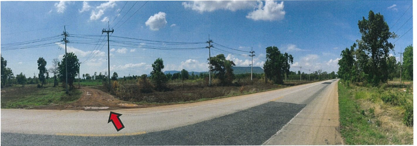
สภาพถนนวิถี (ทล.348) บริเวณหลักกิโลเมตรที่ 26 แยกเข้าถนนสายโรงไฟฟ้า (จุดถ่ายภาพที่ 1)
