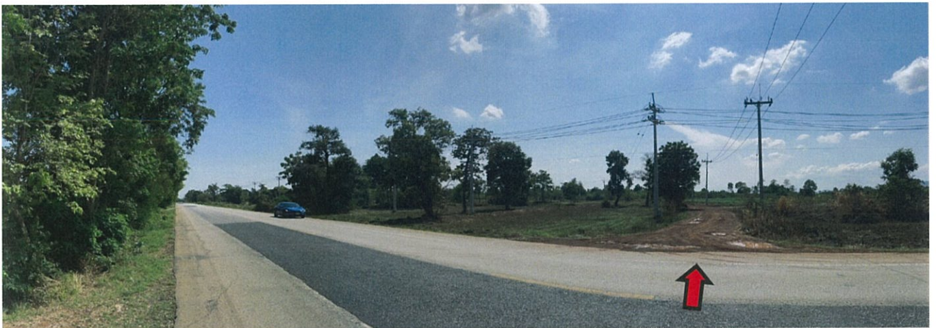
สภาพถนนวิถี (ทล.348) บริเวณหลักกิโลเมตรที่ 26 แยกเข้าถนนสายโรงไฟฟ้า (จุดถ่ายภาพที่ 2)
