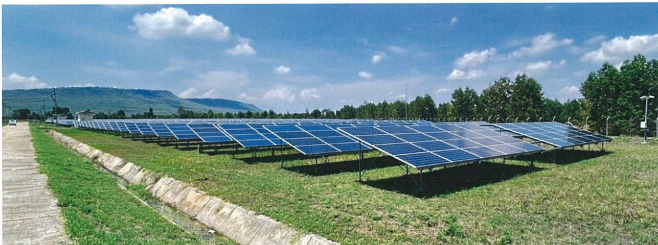
แผงโซลาร์เซลล์ เป็นประเภท Poly Crystalline ยี่ห้อ CANADIAN SOLAR ขนาด 310 W
